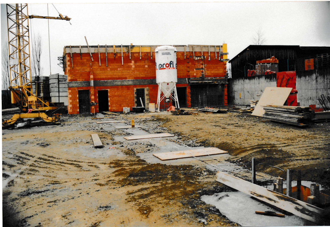
Die Köcher-Fundamente wurden fertiggestellt (Vordergrund) in diese werden anfangs 1993 die Fertigteil-Elemente für die Fahrzeughalle eingesetzt. Foto Josef Ettenauer
