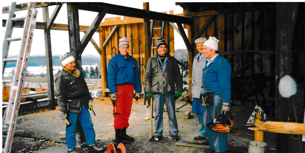
Am 14.11.1992 wurde ein Schuppenteil des Bauhofes in Eigenregie abgetragen
