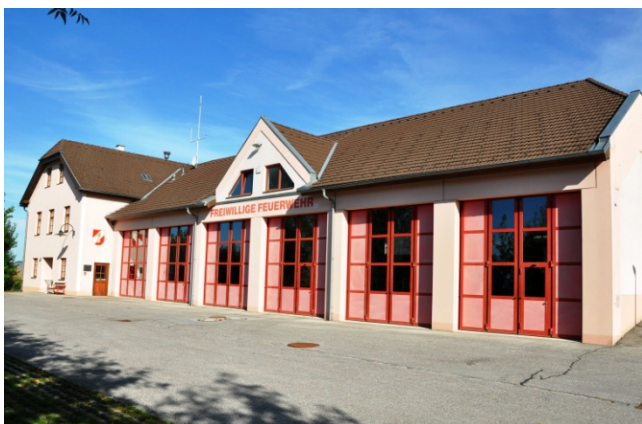
Vor der Tor-Sanierung
