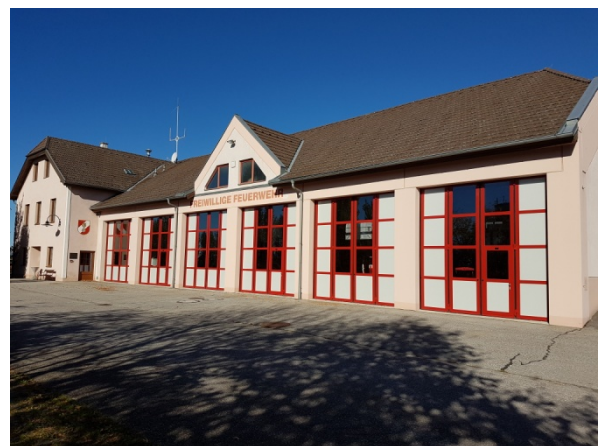
Nach der Tor-Sanierung
